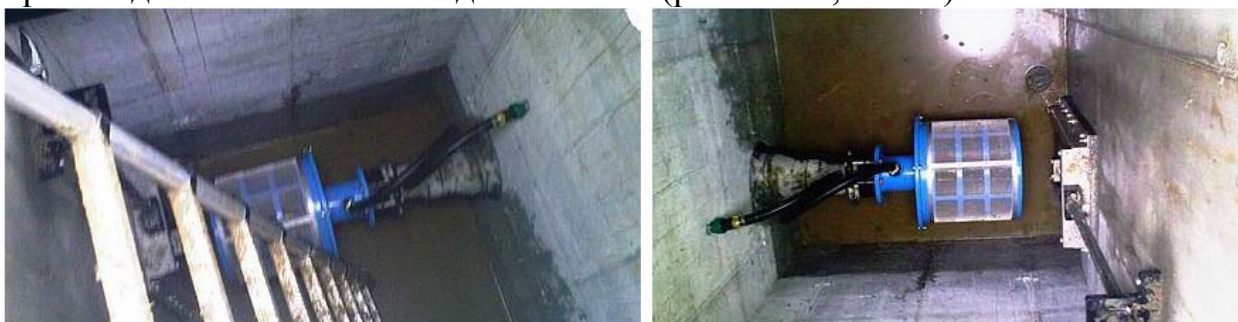
Рис.10.1.3. Установка преднасосного фильтра на водозаборе.
