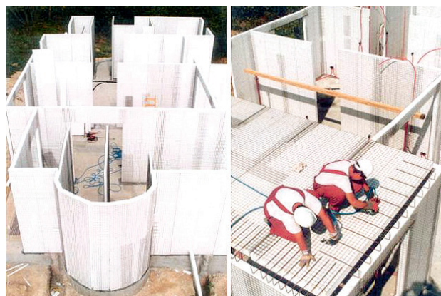
Рис. 4. Возведение дома из пористого бетона
