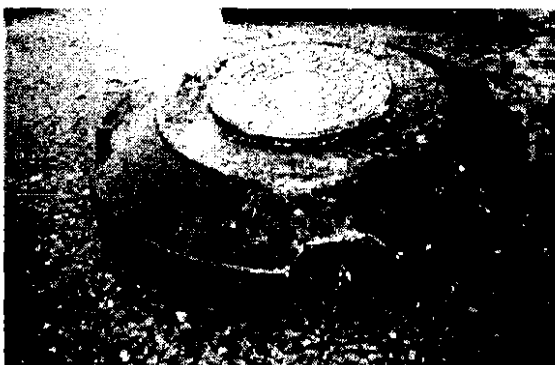
Рис. 6.10. Опорная железобетонная плита для горловин смотровых колодцев
