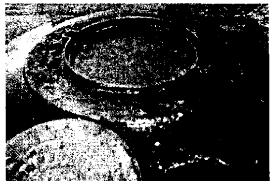
Рис. 6.10. Опорная железобетонная плита для горловин смотровых колодцев
