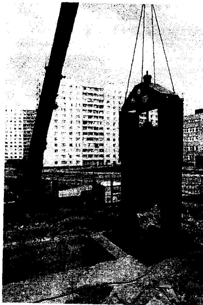
Рис. 6.25. Щитовой затвор на коллекторах
