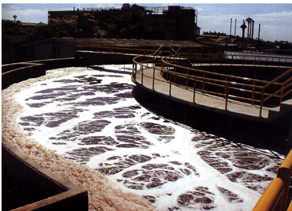
Рис.7.26. Равномерность аэрации при мелкопузырчатых аэраторах
